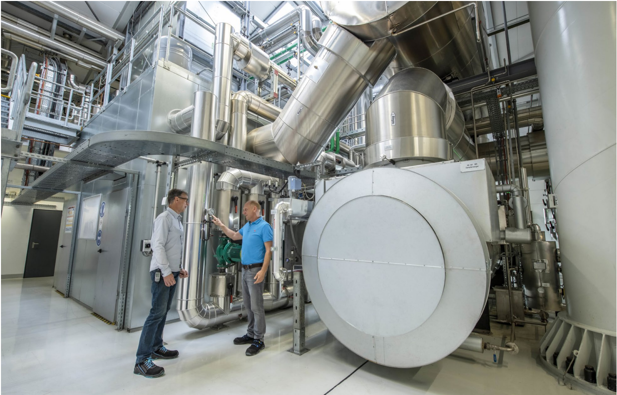
Neben der elektrischen Energie produzieren die KWK-Anlagen auch Wärme. Sie wird für die Produktionsprozesse oder zum Heizen genutzt. Insgesamt vier dieser Anlagen wird tesa bis Ende 2020 in Betrieb haben.
